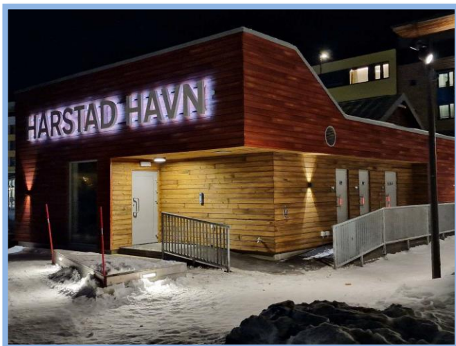
Servicehuset ved gjestehavna
